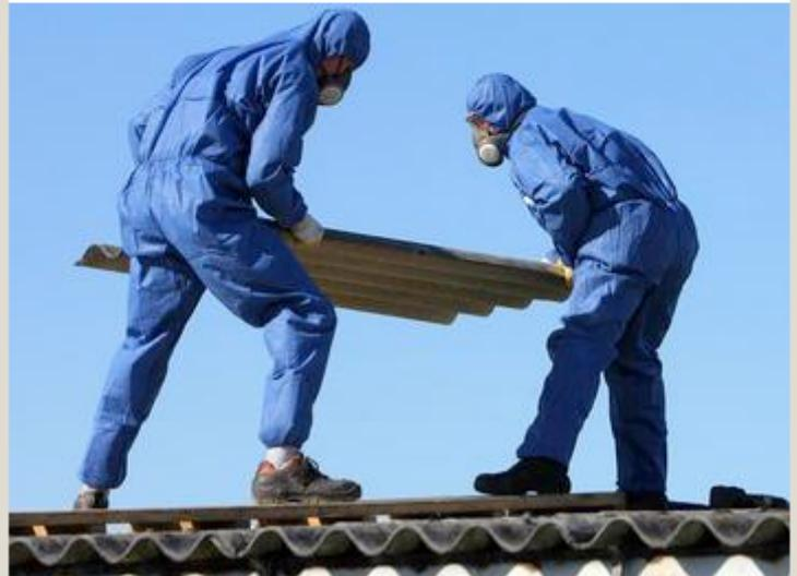
Nur für Profis: Arbeiter in Schutzanzügen und mit Luftfiltern über Mund und Nase entfernen Asbestplatten vom Dach eines alten Garagenkomplexes. © dpa
