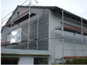
**Festgebundene asbesthaltige Fassadenplatten, die unzulässigerweise mit einem Hochdruckreiniger abgestrahlt wurden. Dieses Vorgehen erfüllt den Tatbestand einer Straftat.**
